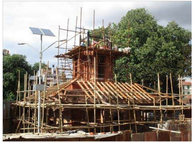
南西から見た様子。スカート屋根の垂木が設置され、尖塔の再建が続いています。（2017年6月26日撮影）
