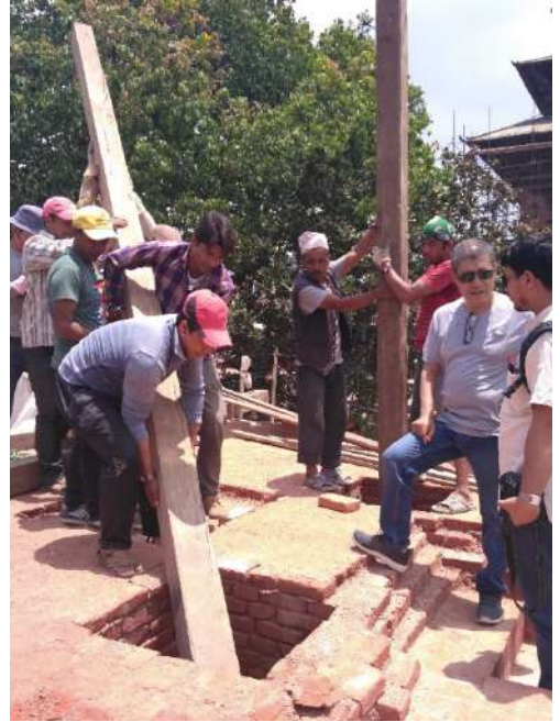
尖塔の四隅に柱を垂直に立てました。レンガ組に埋め込まれる部分にはビチューメン塗料を塗布しました。（2017年5月25日撮影）
