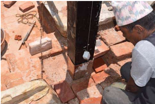
レンガに埋め込まれる柱の下部は、湿気対策としてビチューメン塗料を塗布し銅板で覆いました。（2017年5月25日撮影）
