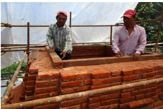
尖塔の大事な所に、水平に木材の壁板を組み入れています。（2017年7月17日撮影）
