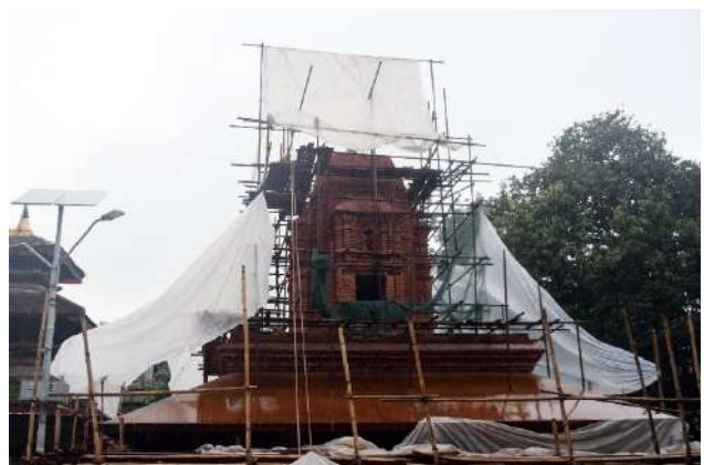
北から見た再建中の尖塔（2017年7月27日撮影）
