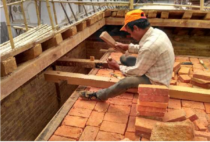
破損して再利用できない部材の代わりに、現場で新しい部材を準備する大工職人（2017年3月31日撮影）
