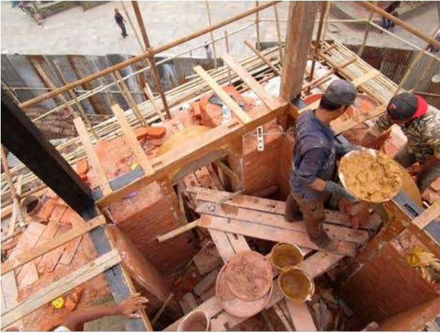
聖所の入口の上にかかるアーチ建設中（2017年6月15日撮影）
