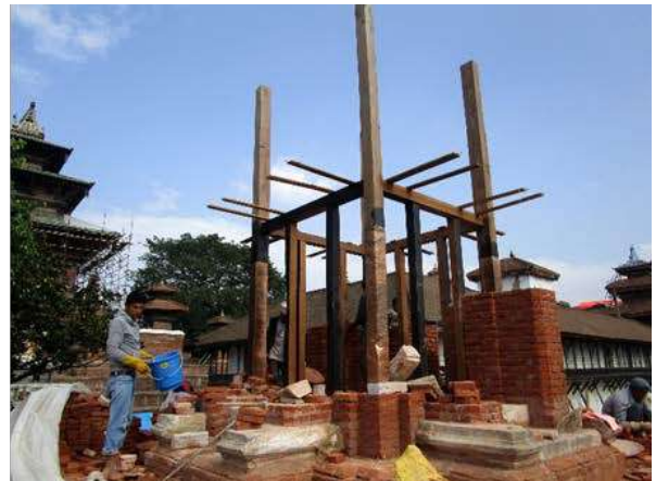
耐震強化のため、四隅の柱は等間隔につなぎ梁を入れて連結しました。聖所の入口の両側に垂直に柱を設置しました。一部がレンガ組の中に埋め込まれるので、柱には、絶えず湿気が浸透する恐れがあります。それを防ぐための必要な手段を講じました。（2017年6月11日撮影）
