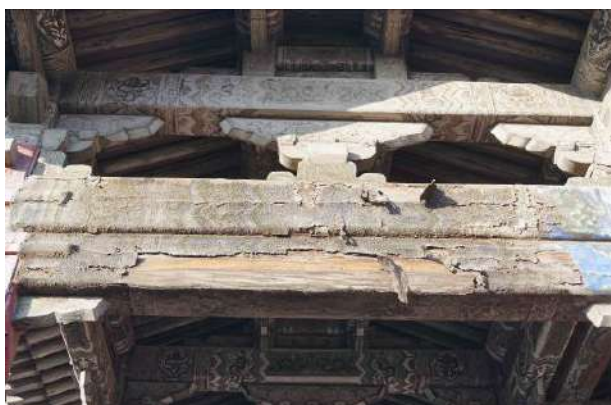
養心殿の部材破損状況
