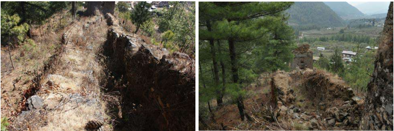
図6. 防備された通路（左）と見張り塔（右） 出典：世界遺産保存部（DCHS）
