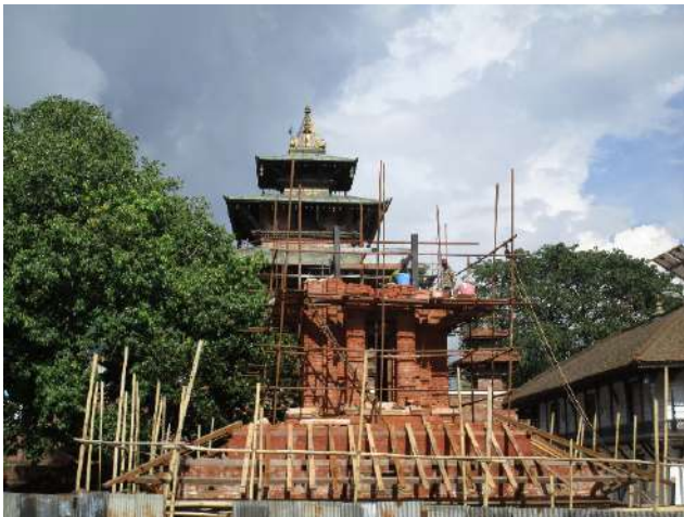
下のスカート屋根に垂木を施工して、尖塔を構成する小塔の再建が続いています。（2017年6月26日撮影）
