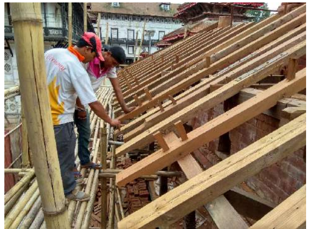
スカート屋根の垂木には新しい木材が使われました。各垂木は正確に配置され、木製留め釘できちんと固定されました。（2017年6月30日撮影）
