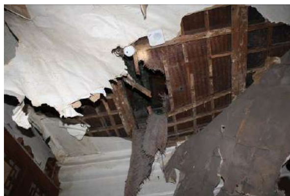
養心殿の部材破損状況
