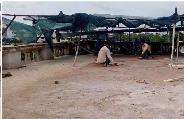
楕円形部屋のマドラス風テラス屋根の石灰コンクリート層が完成しました。
