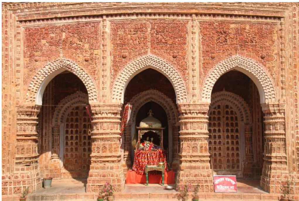
カンタジ寺院の柱、ピラスター（片蓋柱）、アーチ
