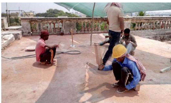
テラス屋根は木製の棒（クルチ）で打ち固めます。
