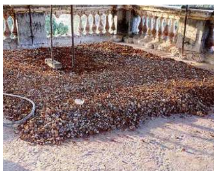
混合前のレンガ破片と焼成石灰（クッピー）。必要な勾配をつけるために敷設。
