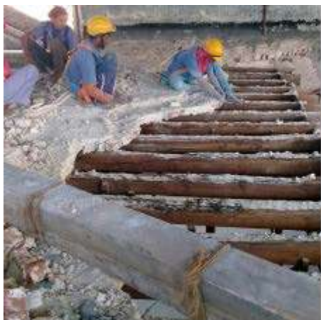
劣化した石灰コンクリートと追加防水工事層を注意深く撤去しました。
