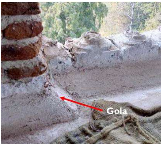
テラス屋根のへり部分は、ゴラ（黄麻の粗布）でふさぎました。
