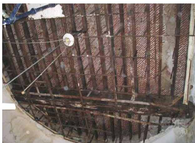
ブリキ製の仮屋根と劣化した梁を撤去した後に露出したマドラス風テラス屋根
