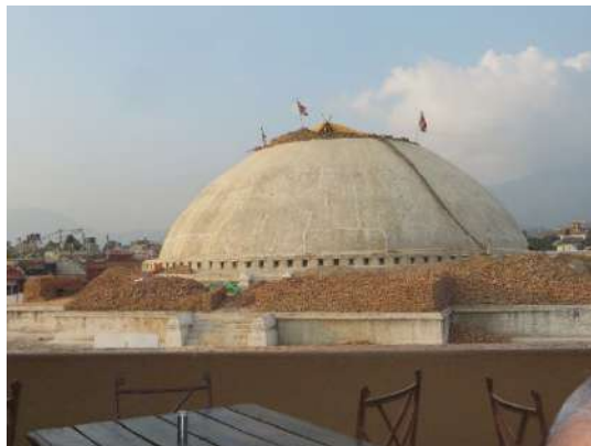
修復のために破損した上部を解体した仏塔
