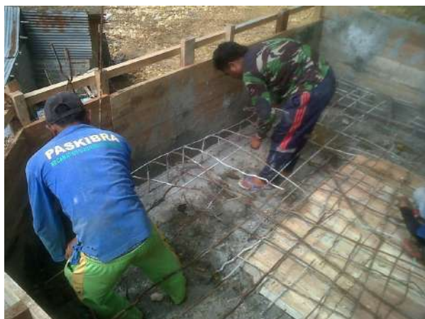
鉄筋の組み立て作業
