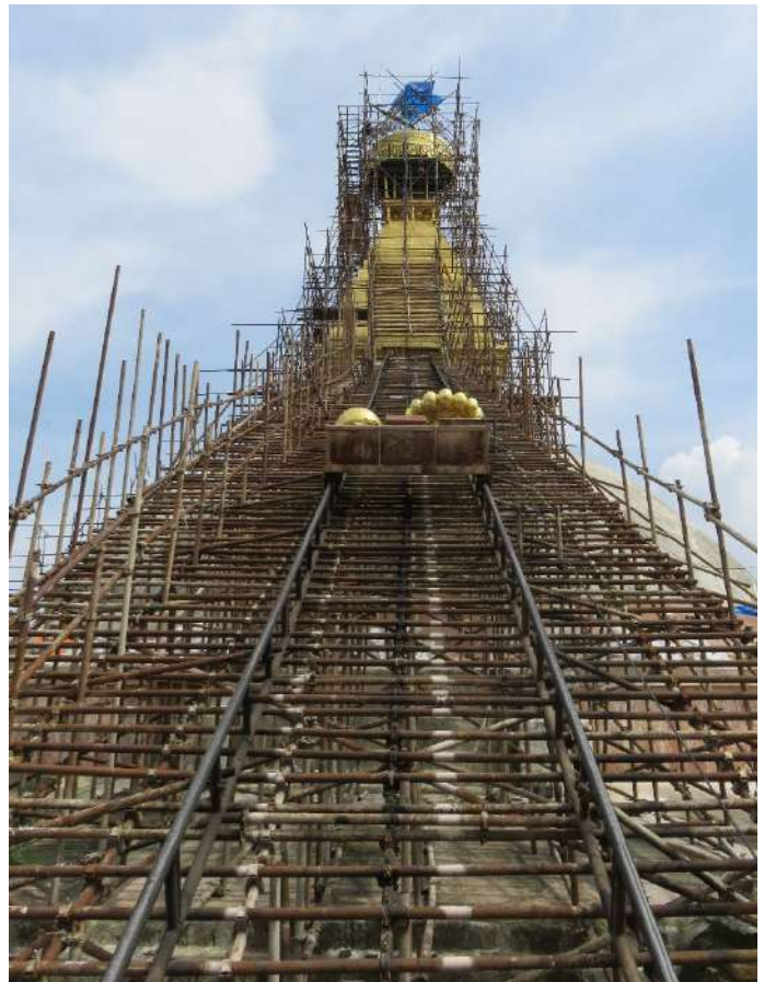
仏塔上部での作業を容易にする金属製の足場
