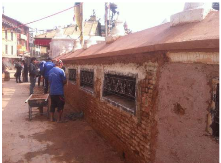
修復の最終段階として、仏塔下部にスルキ（レンガの細粉に石灰を混ぜたモルタル）を塗って仕上げる。
