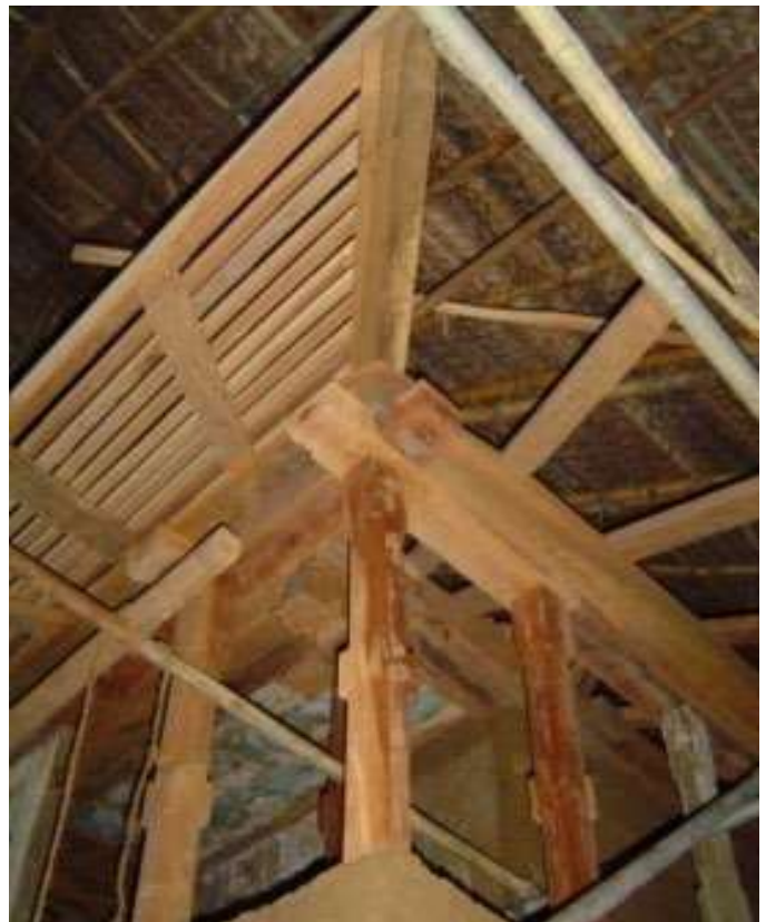
修復工事中の建物
