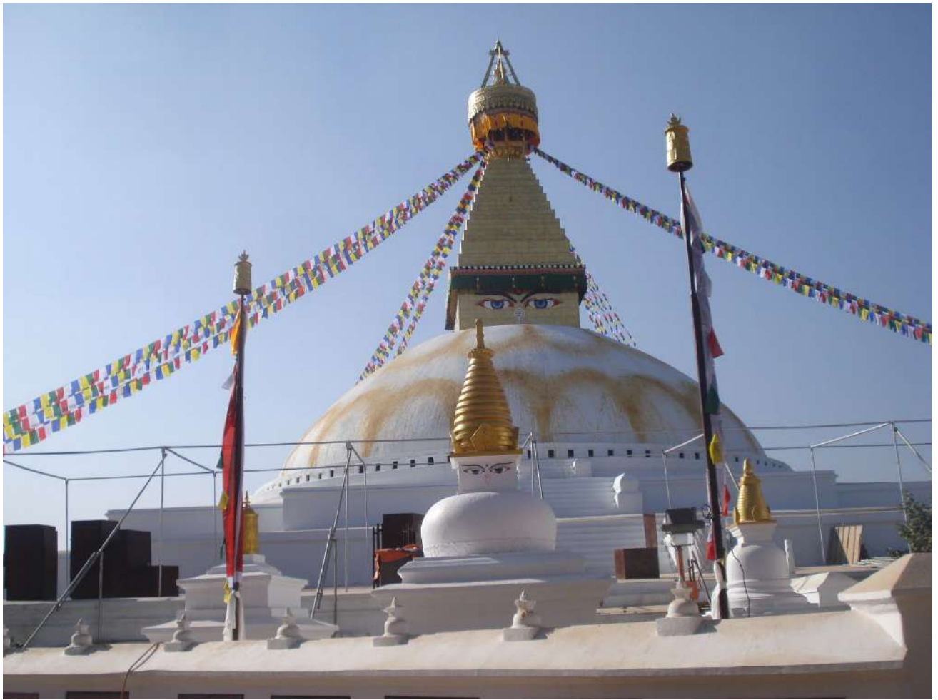
修復工事完了後のボダナート仏塔
