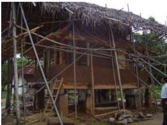
修復工事中の建物
