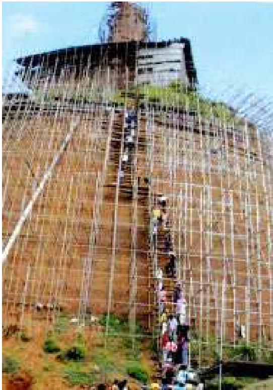
アヌラーダプラのアバヤギリ大塔の修復工事に 参加するボランティアの人々
