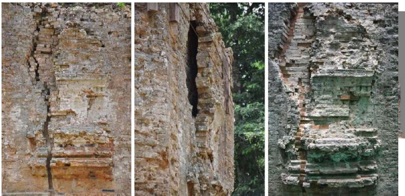
修復例：S8 塔の「フライング・パレス（空飛ぶ宮殿）」壁面彫刻と修復状況（左と中央は修復前、右は修復後）
