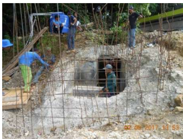
鉄筋の組み立て作業
