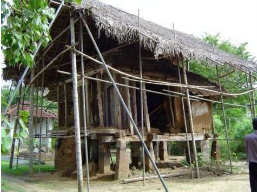
修復工事開始前
