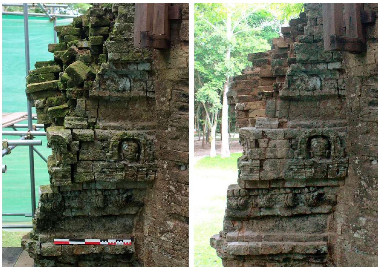
修復例：S10 塔の「クドゥ（kudu／顔面彫刻）」と修復状況（左は修復前、右は修復後）
