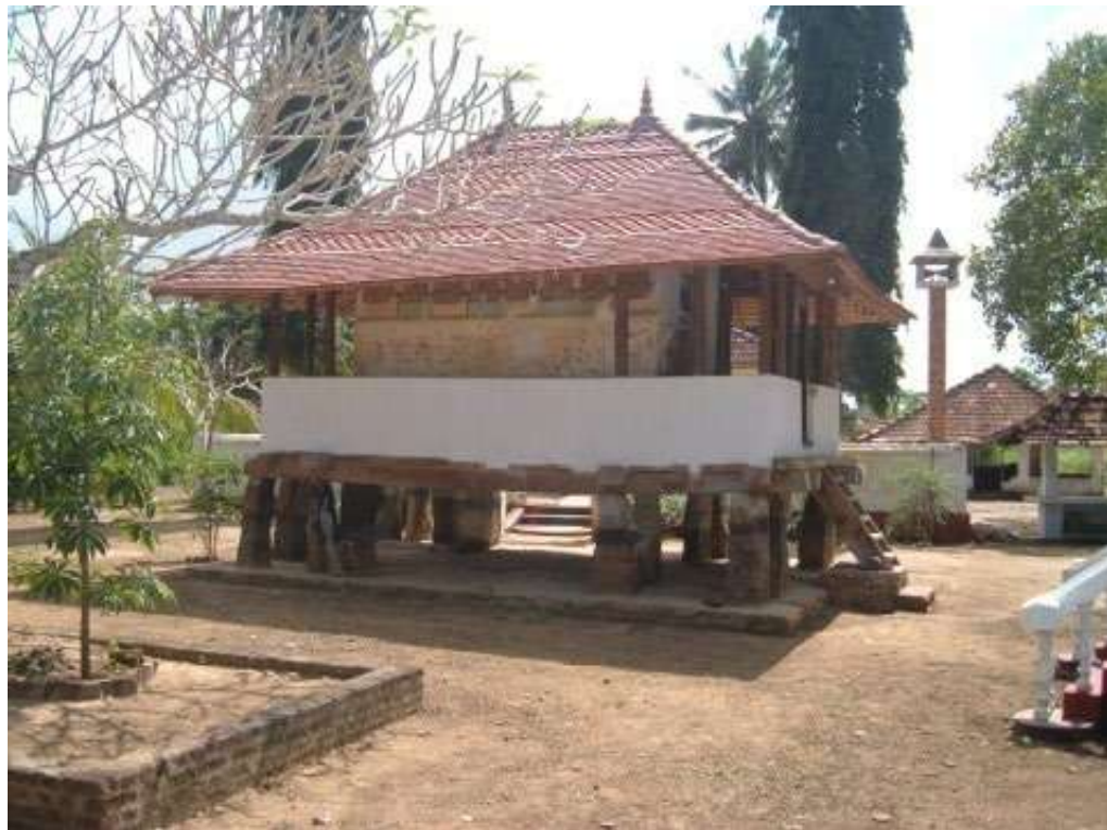
修復工事完了後
