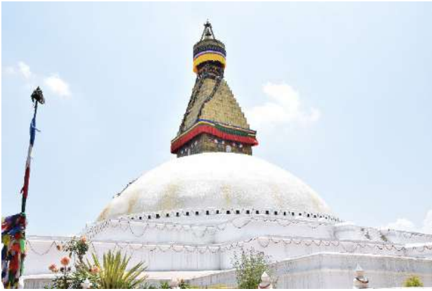
2015 年の地震で破損したボダナート仏塔
