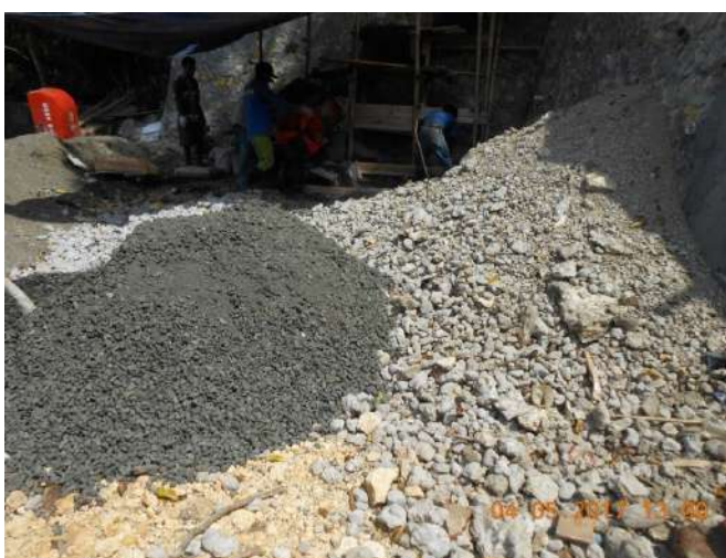
砂と小石を混ぜてコンクリートを作る
