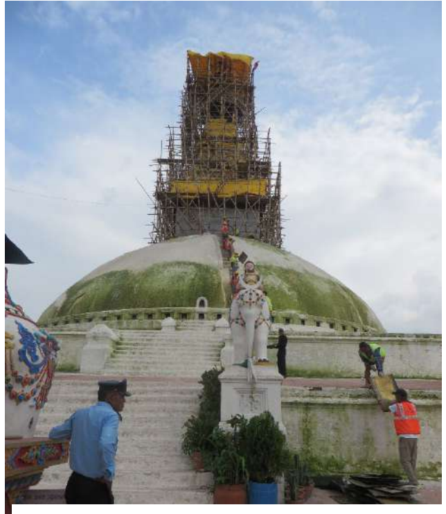
修復工事のためにまず竹製足場を組む。
