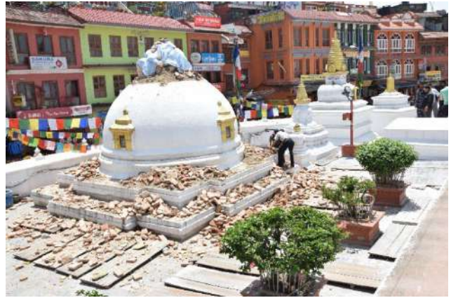
破損したボダナート関連仏塔
