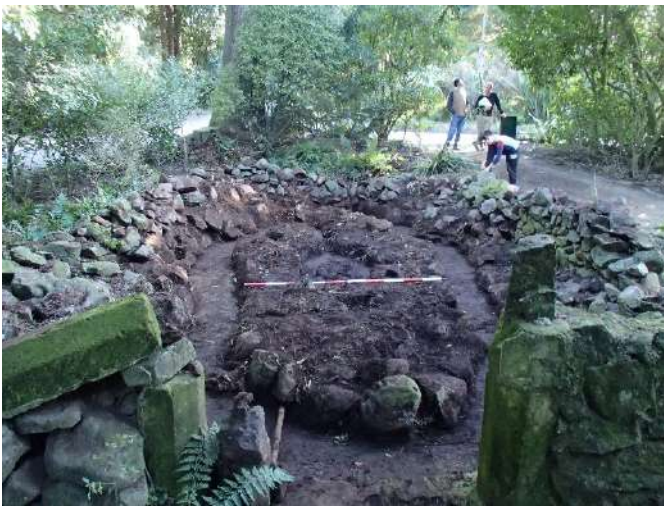
図 33 入口からみたシダ園。レイアウトと崩れた後壁と左壁が見える。給水管が外部からシダ園へと入り池まで続いているのがわかる、2018年8月26日（写真提供：筆者）。
