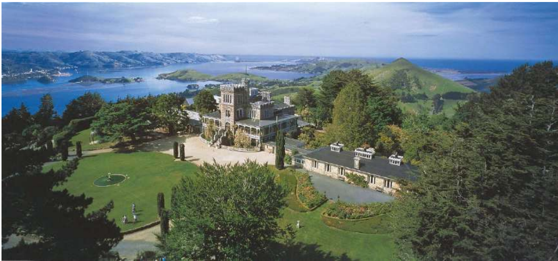
図2 バーカー家により修復されたラーナック城の現在（ダニーデン市の管理会社の許可済）
