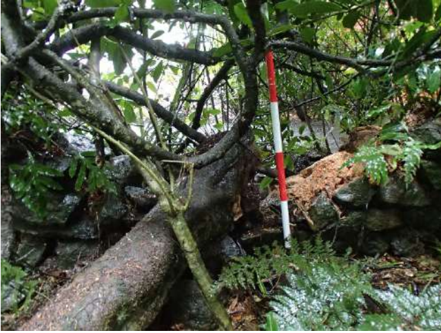
図 15 倒木によって被害をうけた壁 (写真提供：筆者)。
