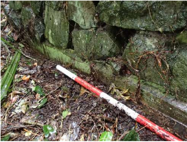
図 21 細長いコンクリート基礎。その上に自然石の石壁が築かれていた。2018年4月29日（写真提供：筆者）。
