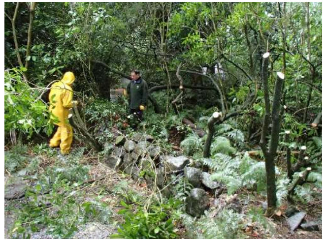
図 18 2018年4月29日の植生除去後、図14の外壁が露出した(写真提供：筆者)。
