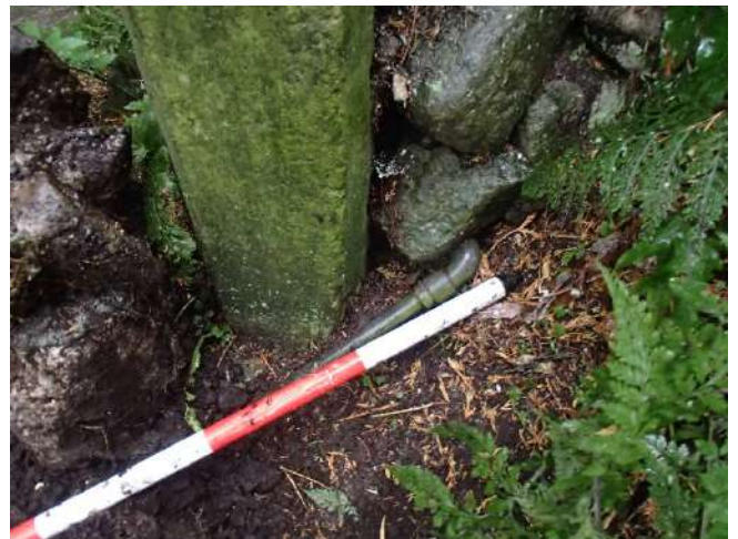
図 24 外部の水源から給水管がシダ園へと通じていた（写真提供：筆者）。
