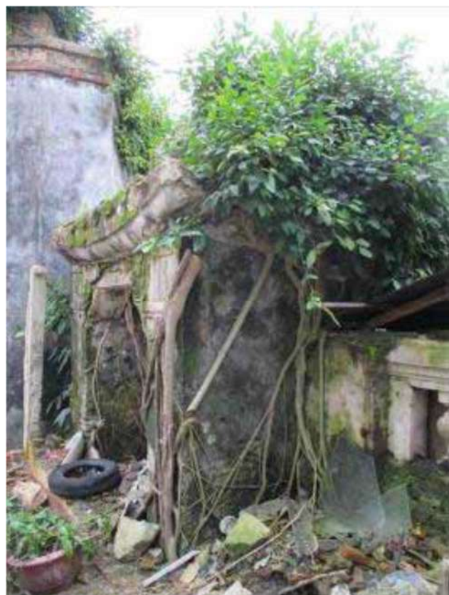
4. 門を破壊した木の根
