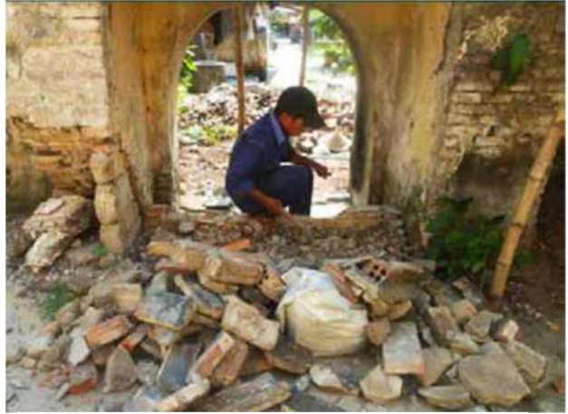
10. 門に悪影響を与えていた設備の解体
