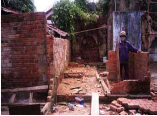
9. 門の前に建てられていた家屋の解体
