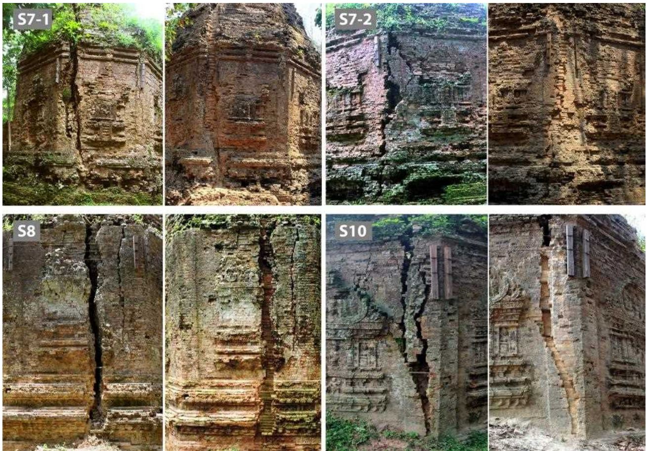
実例：部分的緊急保存工事、修復前と修復後
