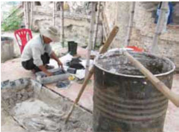
25. 伝統的石灰モルタルを混合する熟練工
