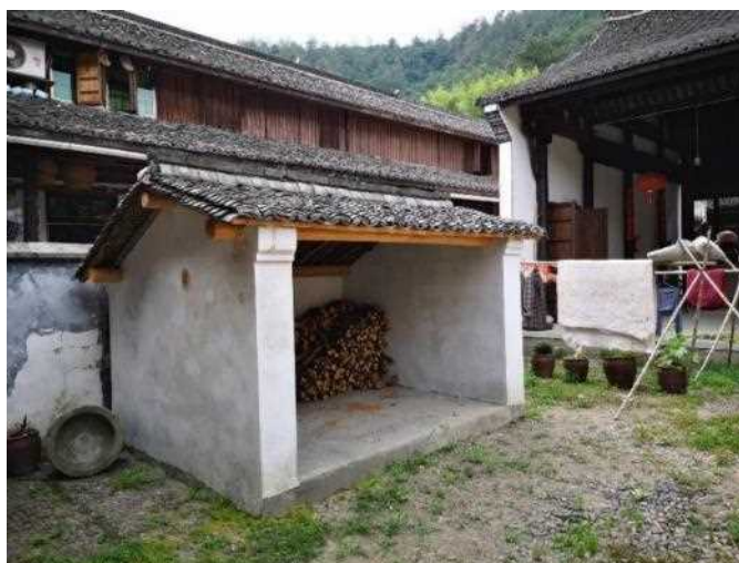
伝統的薪小屋の修復：浙江省斯宅村
