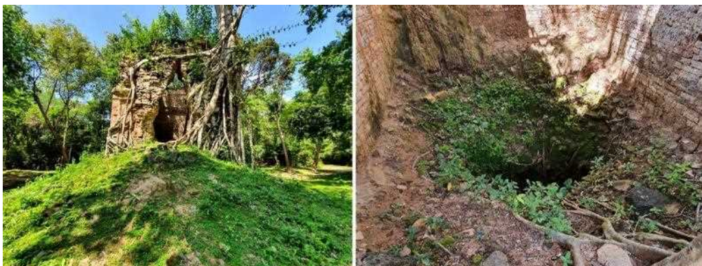
N24 塔：正面からみた盗掘による堆積土壌の山と土台部（左）、不法発掘坑の内部（右）
