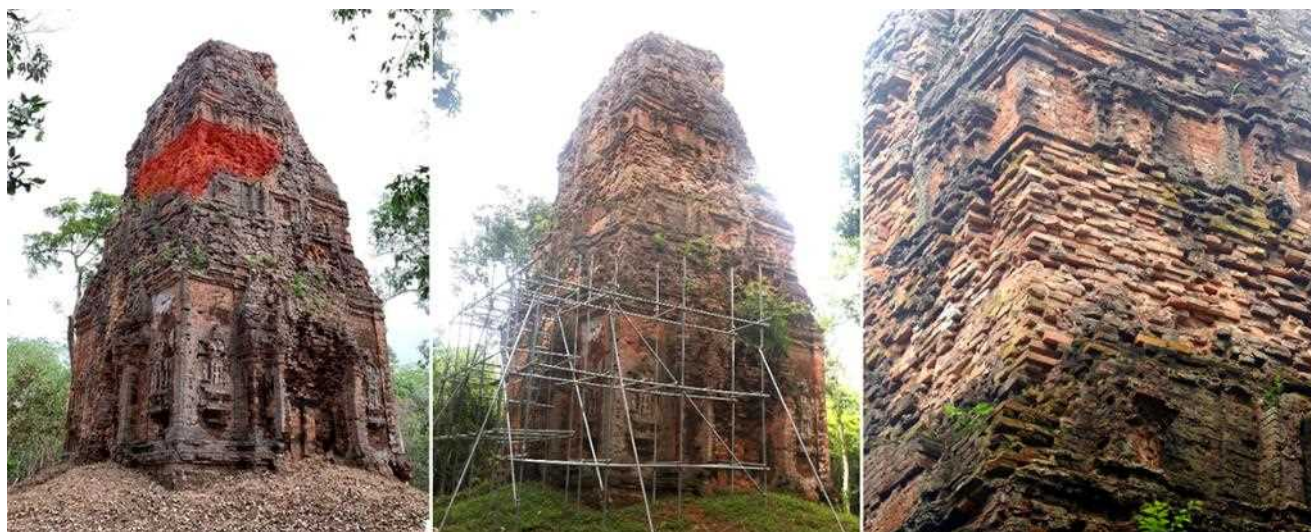
実例：Z1塔の部分的緊急保存工事、修復前（左）修復中（中央）修復後（右）
