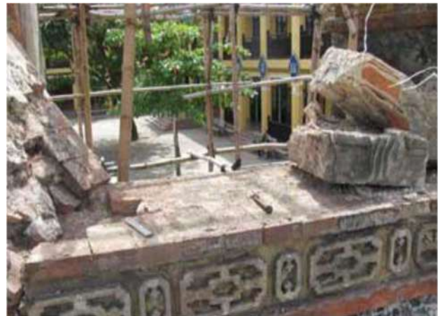
14. 破損部材はきれいにし、強化処理を施した。
