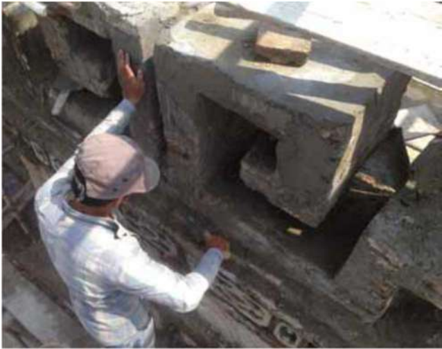
15. 破損部材は補修後、元の場所に再設置された。
