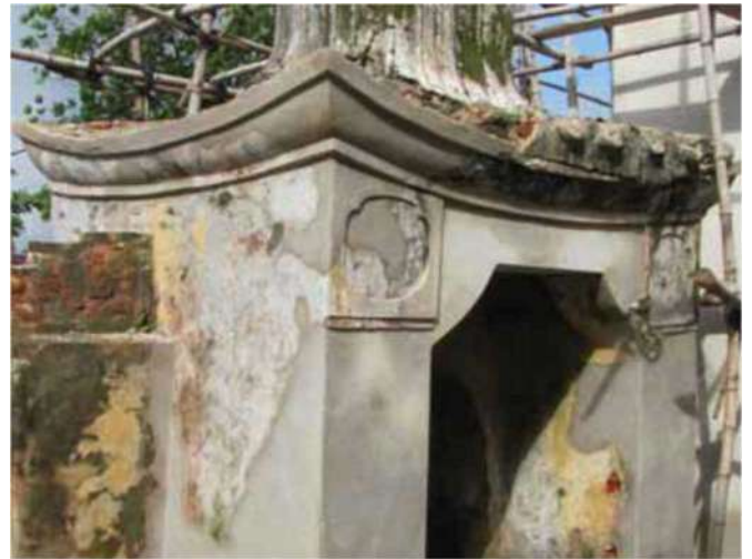
18. 石灰モルタルを塗った壁
