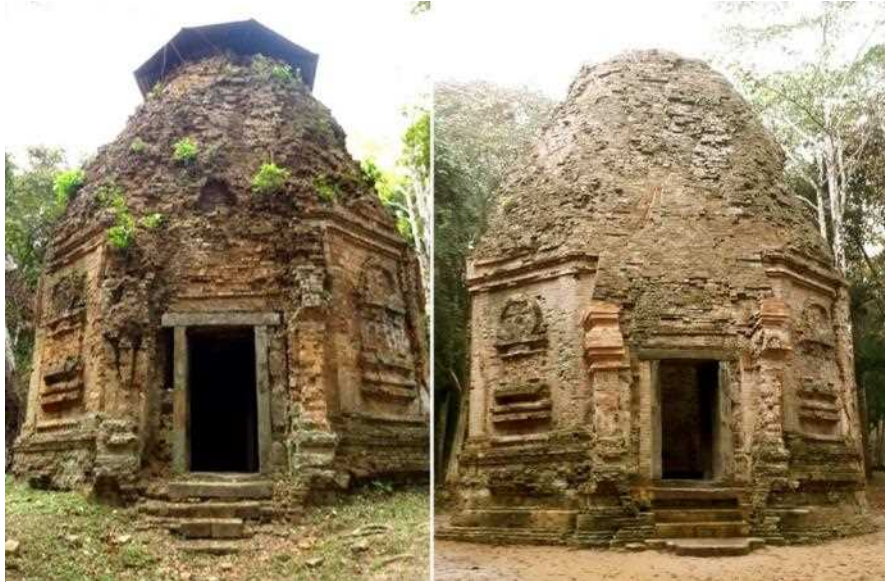
S1 塔の修復前と修復後
