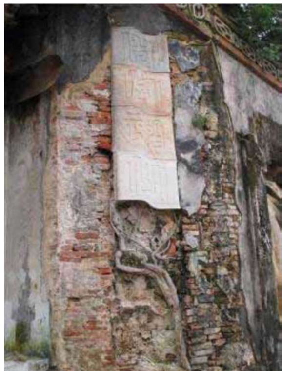
5. 壁から部材が落下した。
