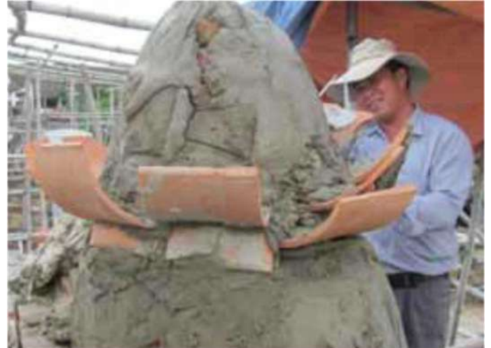
16. 煉瓦、屋根瓦、石灰モルタルなどで修復した煉瓦工事部分
