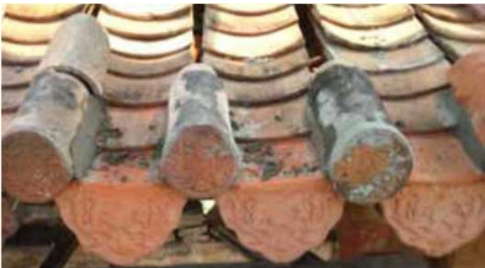
19. 修復後の屋根
