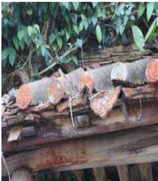
6. 部材の大部分が腐食していた。
