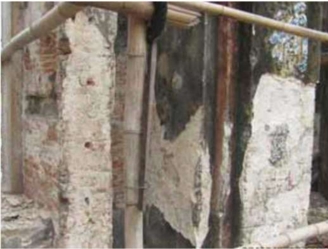
17. 薄片化した石灰モルタル壁を取り除いた。
