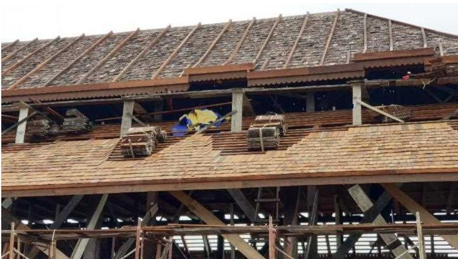
リリー要塞の修復には二層式屋根が採用された。それによってベリアン材こけら板の下部の視界を妨げることなく、適切な断熱材を取り付けることができた。
