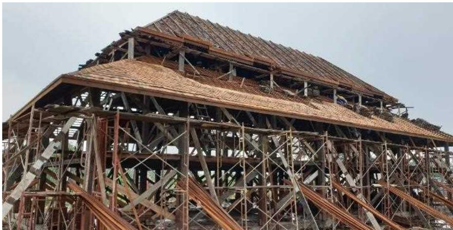
修復工事の間、リリー要塞では建物の解体、建築部材の回収・保管・保存処理・再構築などの大規模改修と修復が行われた。
