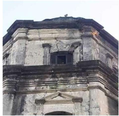
聖リタ・デ・カッサ教区教会の鐘塔の亀裂（セイント・リタ）
