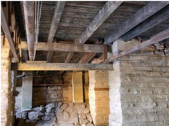
図8. 桁や梁が朽ちて、耐力が低下。
