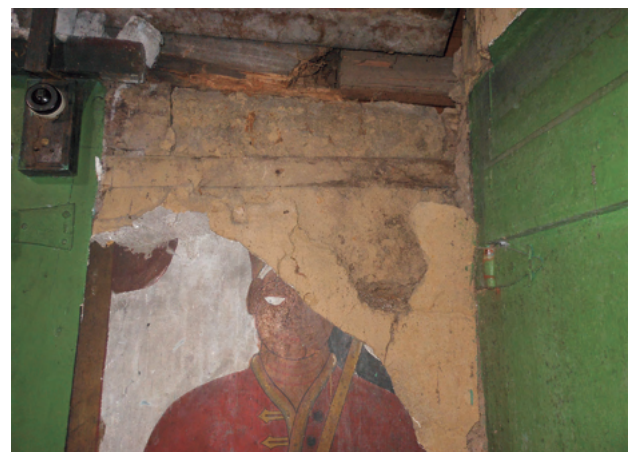
Fig.16. Deep lacunae in the support (wall no. A)
