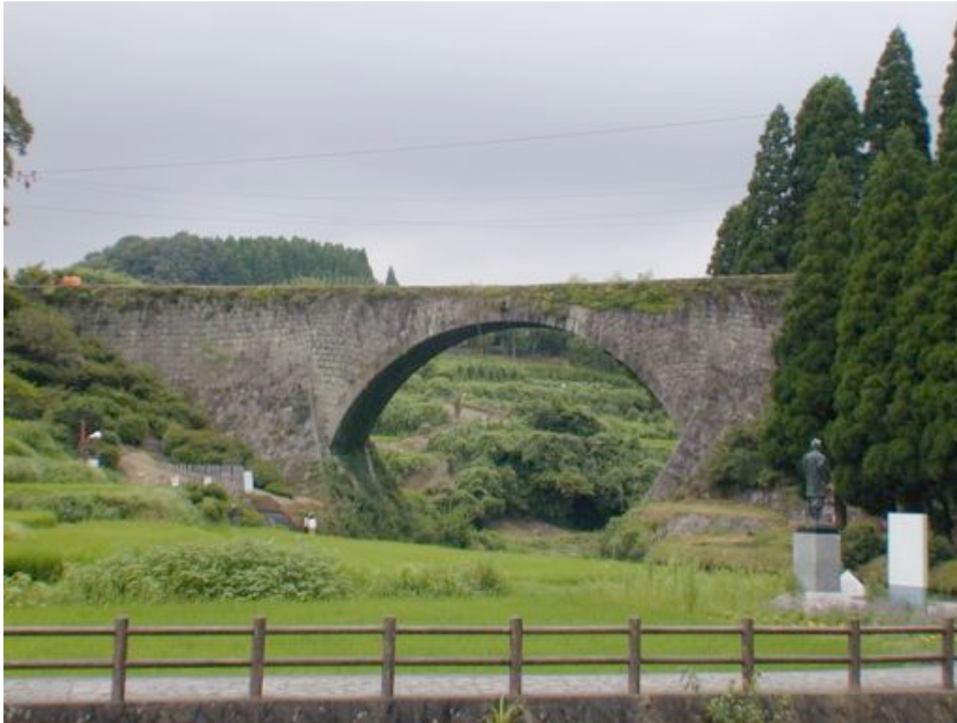
Tsu-Jyun-Kyo Bridge (Kumamoto, Japan)
