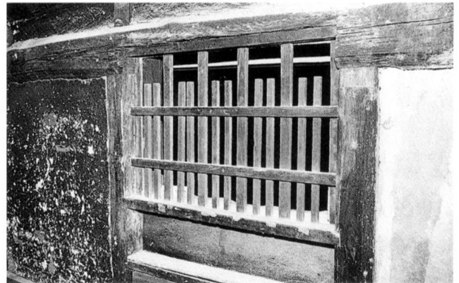
図39 窓の旧位置痕跡
