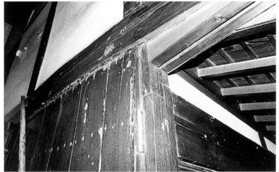
図38 チャノマ上手の根継ぎされた柱
