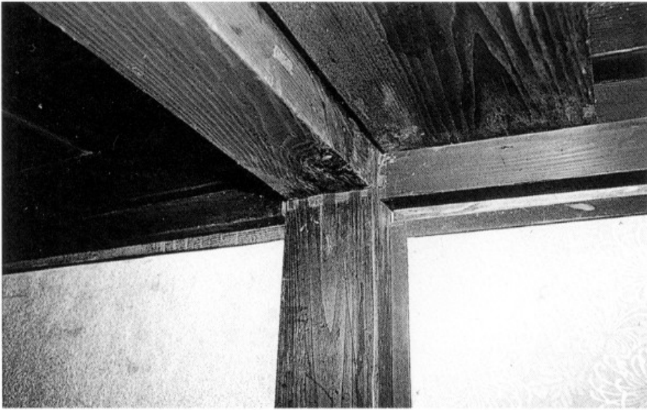
図36 ミセノマ入側柱のヒバタ痕跡
