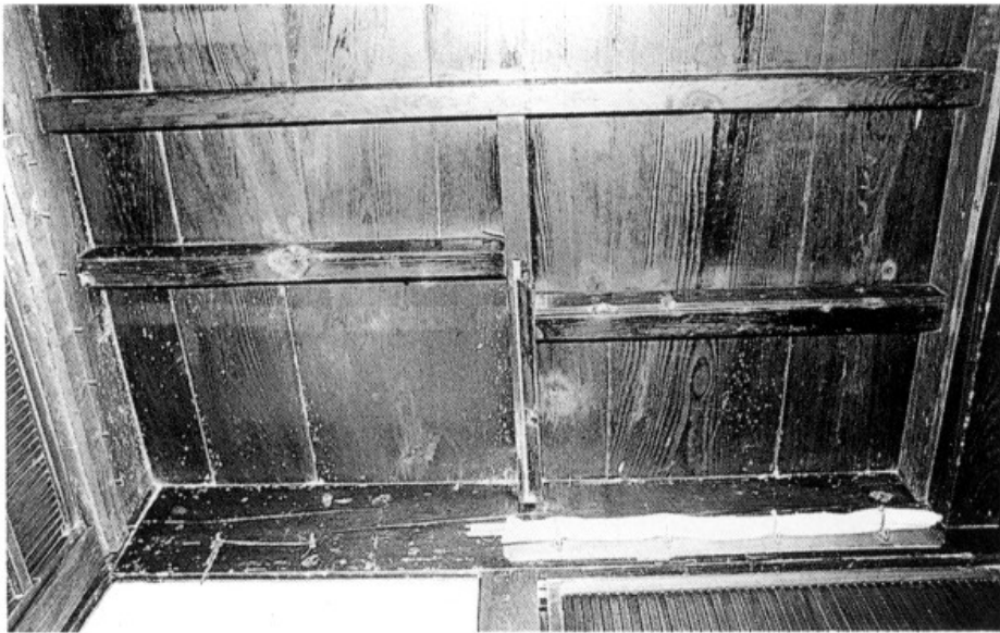
図37 ミセノマ天井の上り口痕跡
