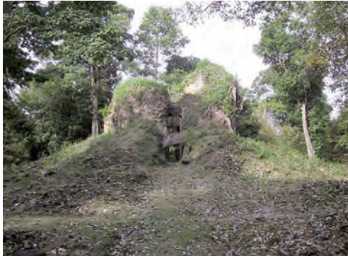
塔東面（修復前） East face of tower (before restoration)
