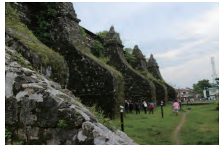
バットレスに生い茂る植物 Vegetal growth on the buttresses
