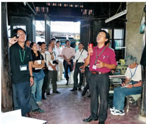
参加者による建物破損状態の説明
