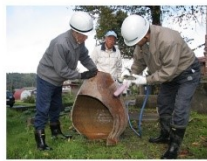
応急処置作業 (中越沖地震)
