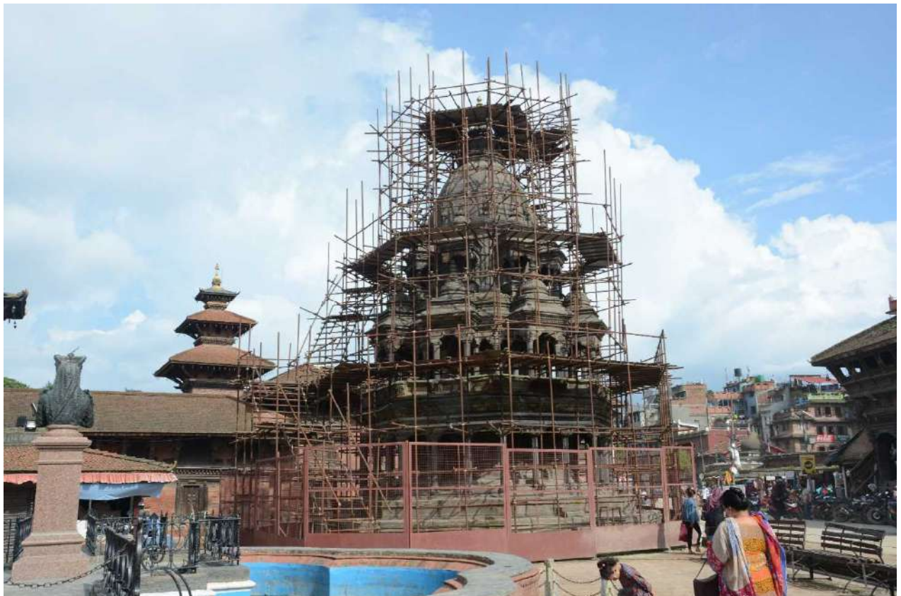
2-11 工事中のラダ・クリシュナ（八角形）寺院
