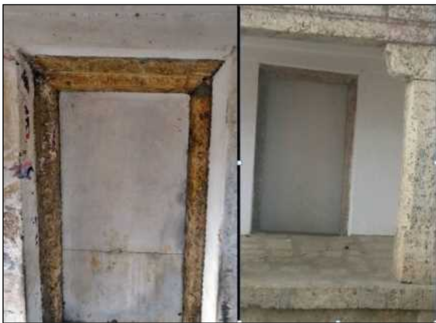
図 20 扉の修復工事前（左）と後（右）
