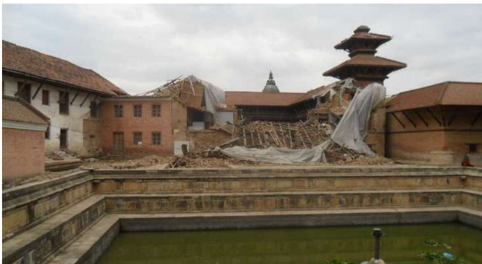
1-1 地震により倒壊したスンダリ・チョーク
