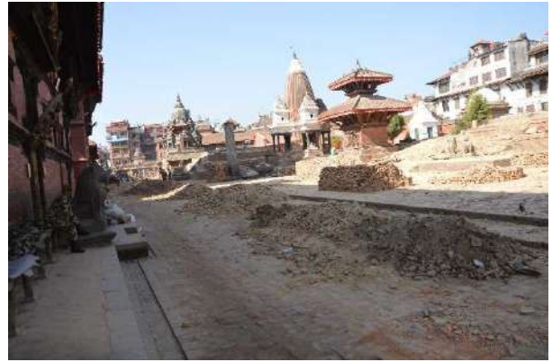
1-3 地震により倒壊したハリ・シャンカー寺院（石塔後部）
