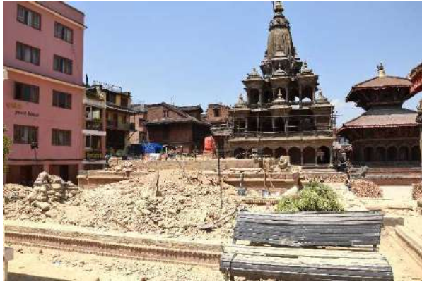
1-2 地震により倒壊したチャル・ナラヤン寺院
