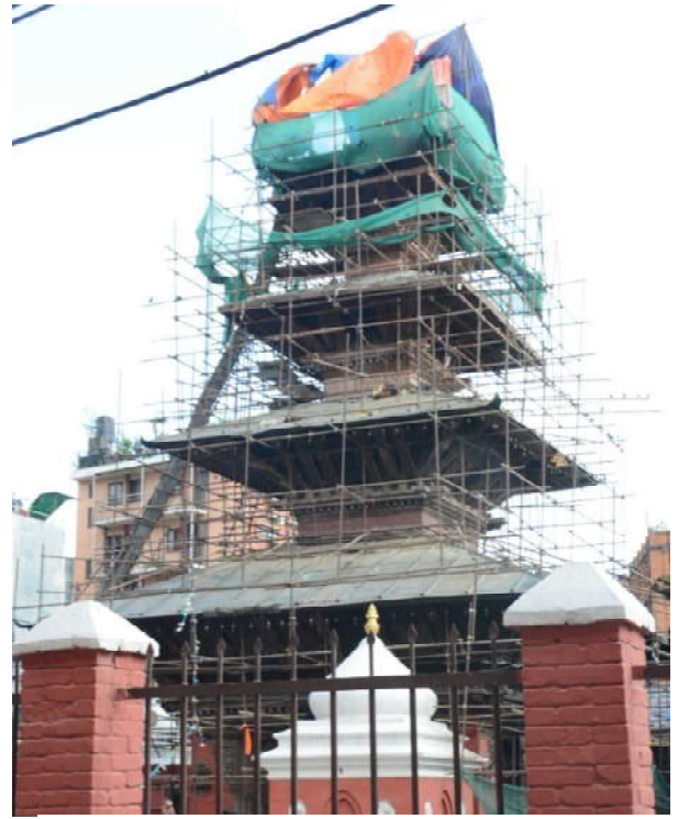
2-10 工事中のクンベシュウォル寺院
