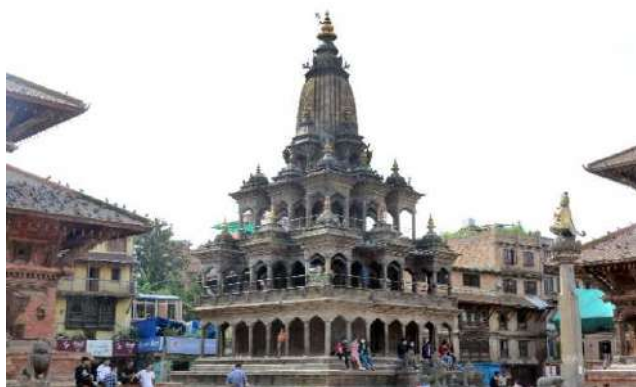
2-4 修復後のクリシュナ・マンディール寺院
