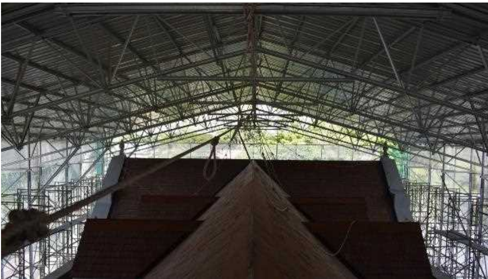
旧サラワク博物館高さ 14.6mの仮設屋根は、修復工事中に快適な作業環境を提供した。
