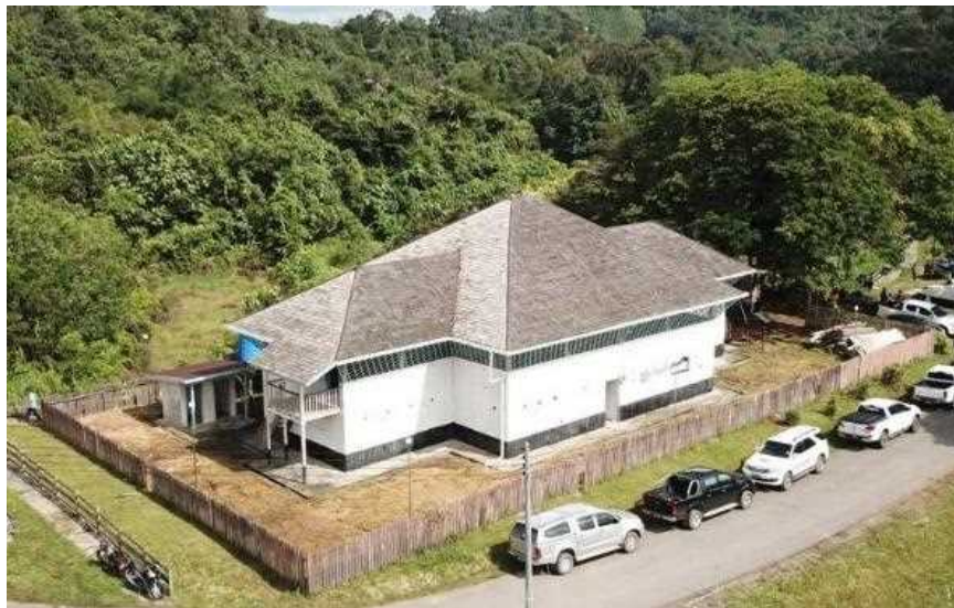
仮設屋根設置前のブルック要塞の空中写真
