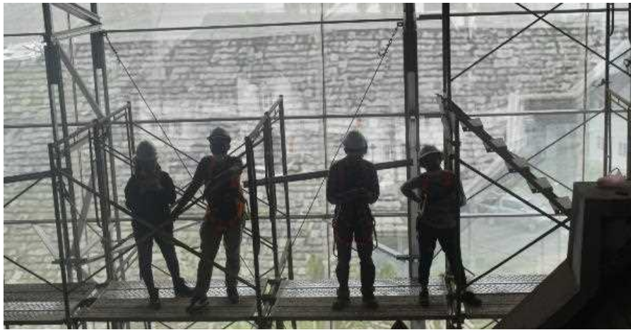
旧サラワク博物館の門型フレーム仮設屋根は、コンクリート基礎部、亜鉛メッキの軽量鉄骨の桁、フライ支柱ケーブル線などを採用した。
