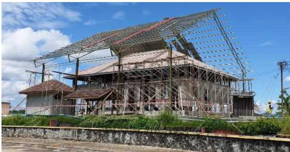
エマ要塞では、10.5m の足場型仮設屋根が建てられた。
