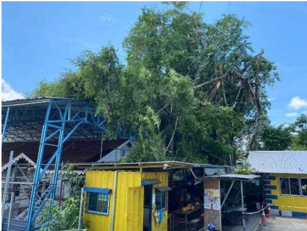
2020年8月22日の夕方（工事期間中）、豪雨で近くの木が倒れて建物を直撃した際に、仮設屋根が館長の館を破壊から守った。
