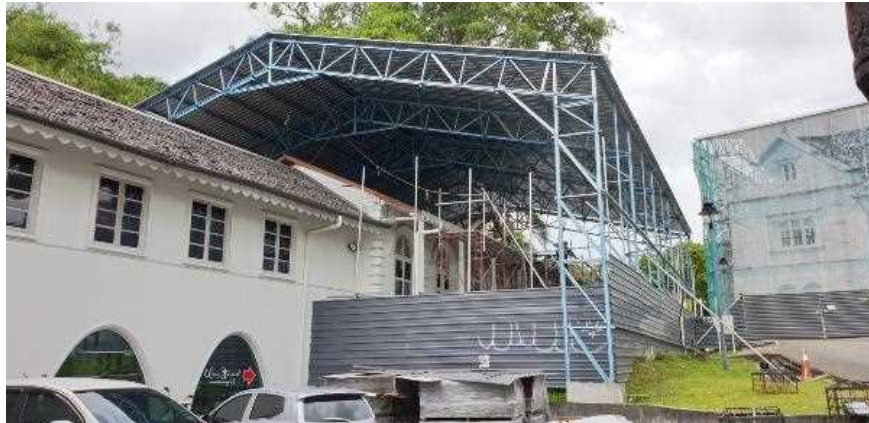
館長の館の仮設屋根は高度な汎用性、保護性、カプセル化を提供した。旧サラワク博物館が右側遠くに位置している。
