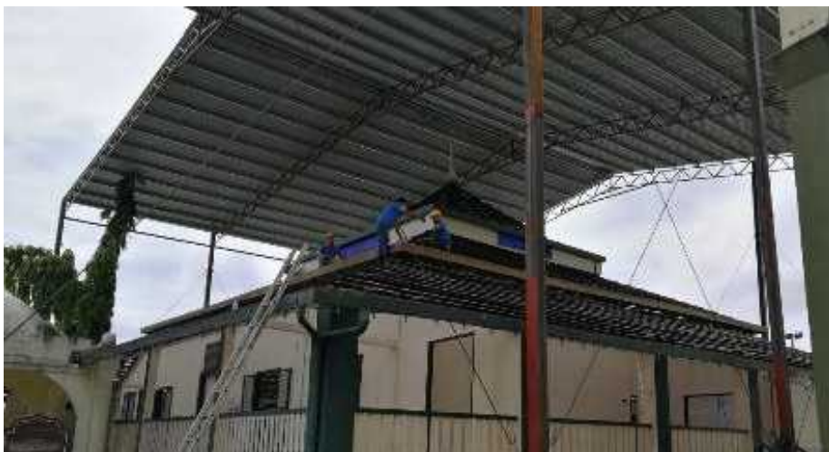
アル・カディム・モスクに設置された仮設屋根は、地面のコンクリート土台にボルトとナットで固定された鉄骨柱によって支持されており、鉄骨柱は結束バンドでも補強されていた。
