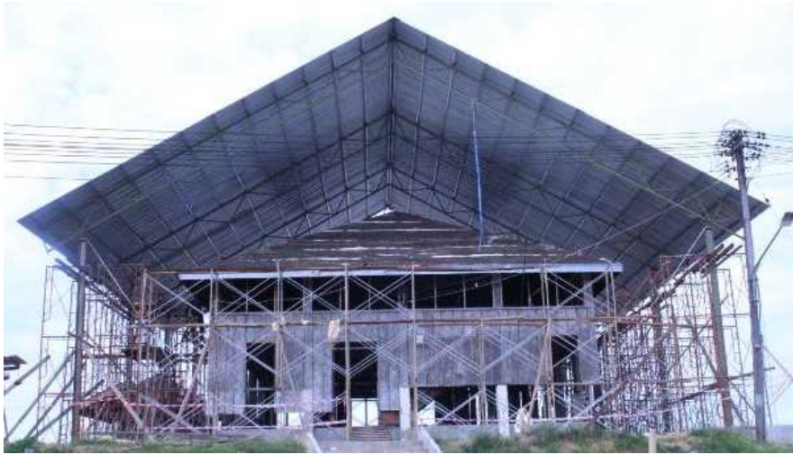
エマ要塞をおおう足場型仮設屋根を正面から見たところ。仮設屋根は、屋根板をベリアン材（テツボク）に葺き替える期間中に、過酷な天候から要塞を保護した。
