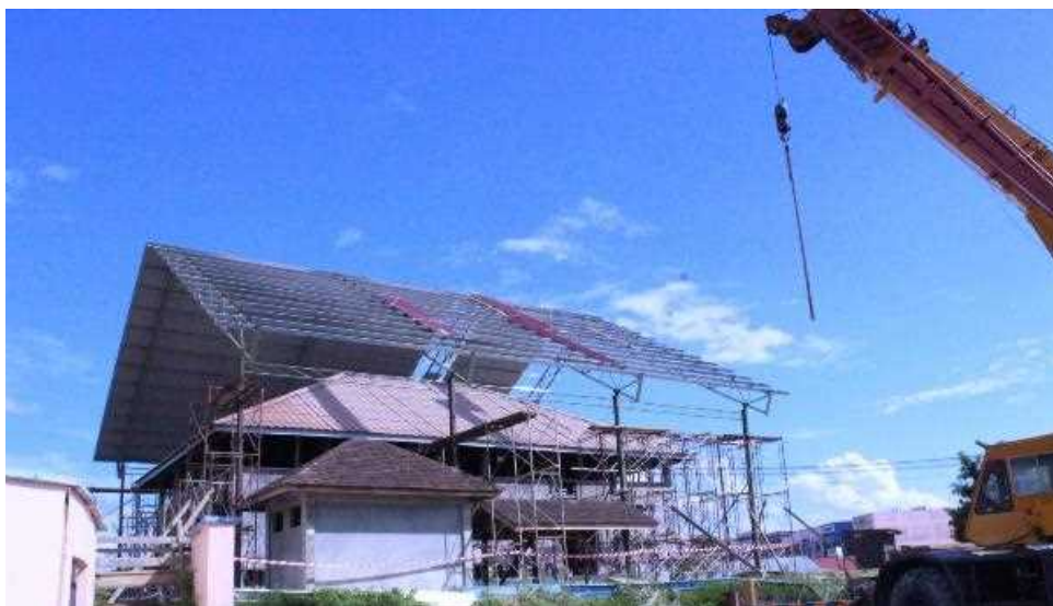
エマ要塞の仮設屋根設置の際は、敷地の制約があり移動式クレーンが使用された。
