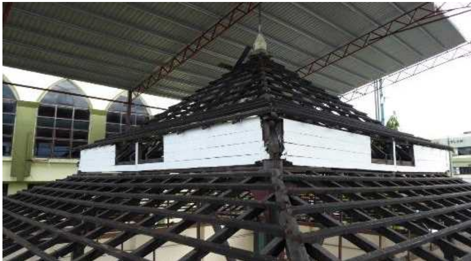
古い屋根を新しい屋根材と取り替える際に、アル・カディム・モスクの保護のために、高さ 16m の仮設屋根が建設された。
