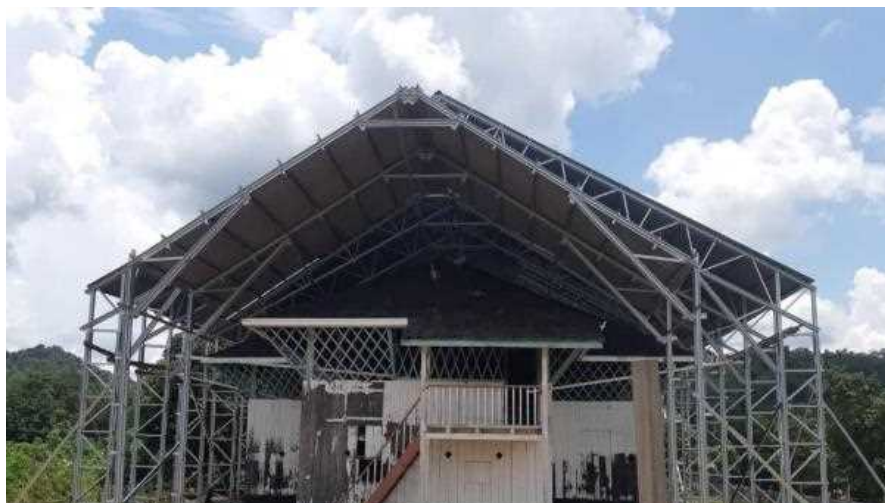
ブルック要塞では、高さ 12 メートルの鋼トラス・フレームの仮設屋根が建てられた。
