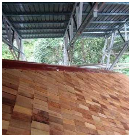
ブルック要塞の新しいベリアン（テツボク）材のこけら板の接写写真
