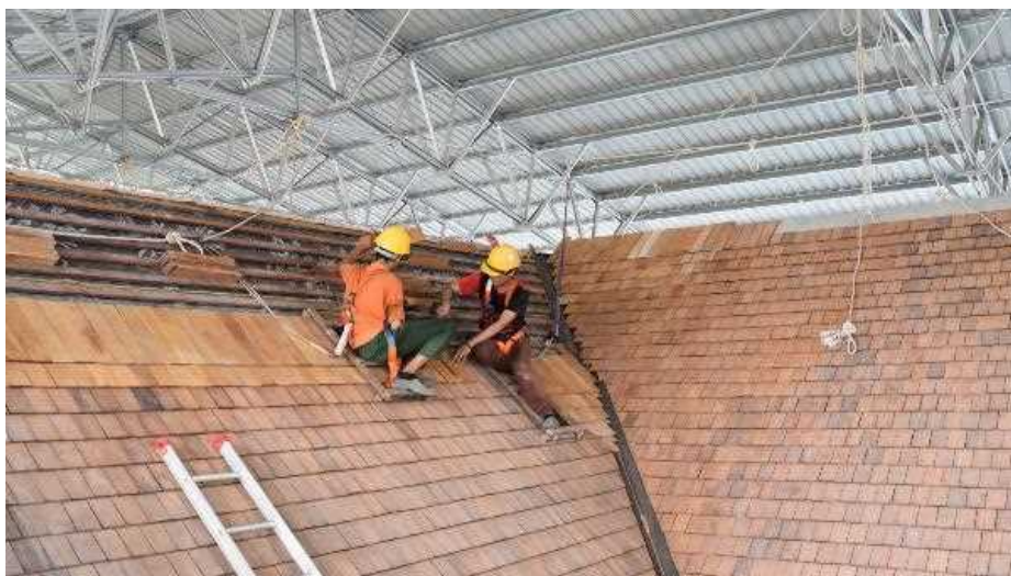
旧サラワク博物館では仮設屋根の下で、屋根職人がベリアン（テツボク）材のこけら板を屋根にうまく敷設した。
