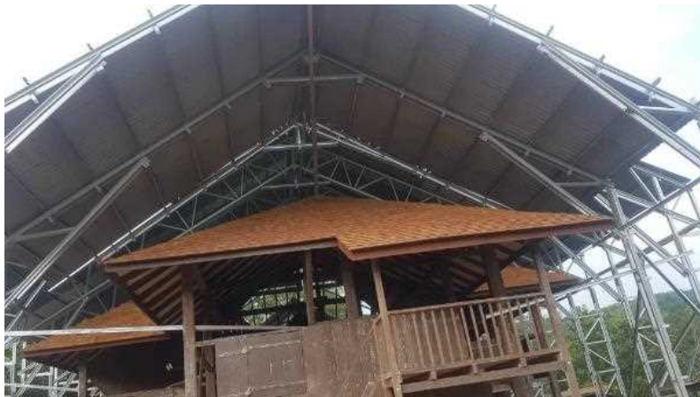
全工事期間中、仮設屋根はブルック要塞の屋根を厳しい天候、粉塵、環境被害などから保護した。
