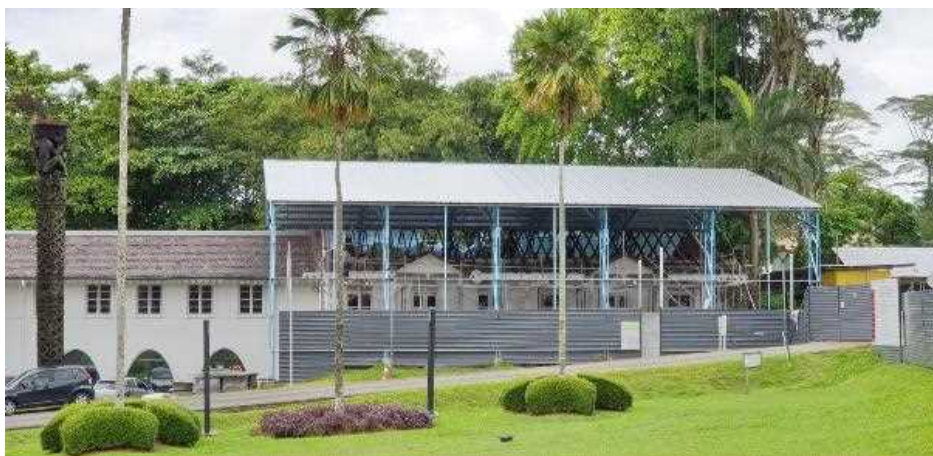
館長の館の修復作業中には、門型フレーム屋根システムを用いた高さ 6.5 メートルの仮設屋根が設置された。
