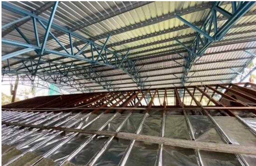
新しいペリアン（テツボク）材のこけら板を葺く前の館長の館の仮設屋根
