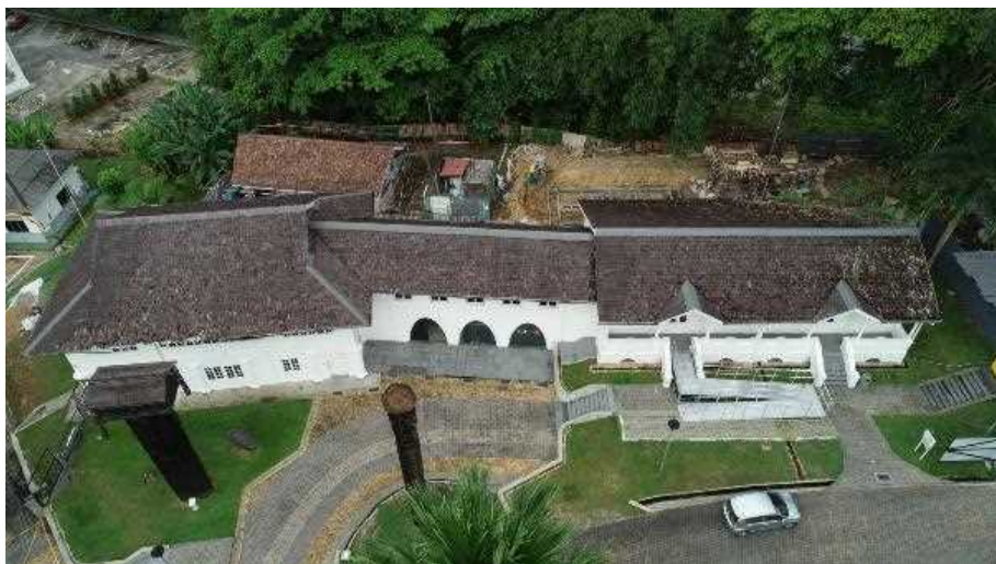
仮設屋根設置前の館長の家（右端）の空中写真
