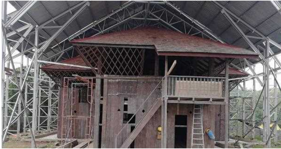
ブルック要塞の仮設屋根は、特にベリアン（テツボク）材のこけら板を屋根に葺く間、快適な作業環境を提供した。
