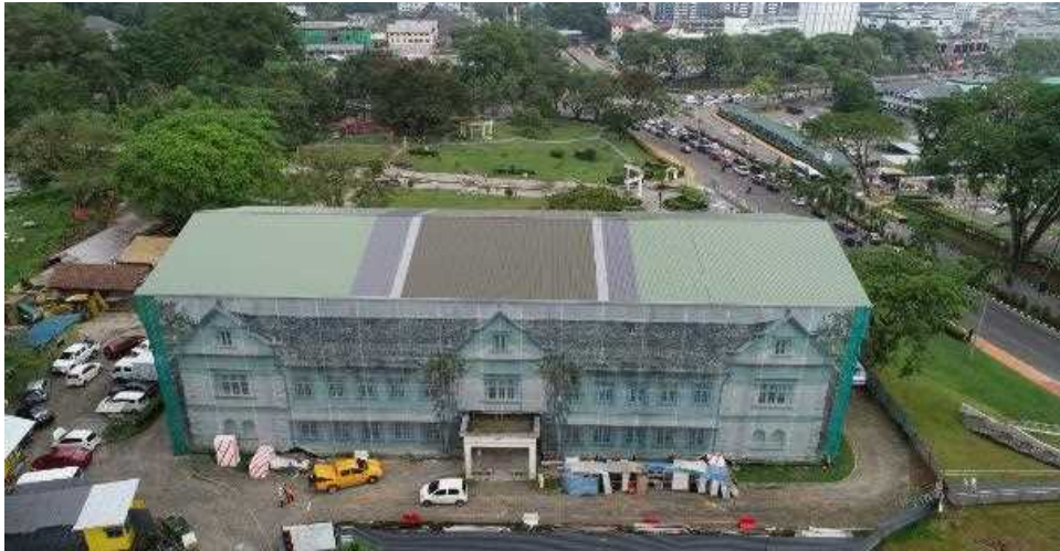
幅の広い仮設屋根におおわれた旧サラワク博物館の空中写真
