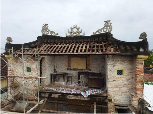
薄片化したモルタル壁が取り除かれた。
