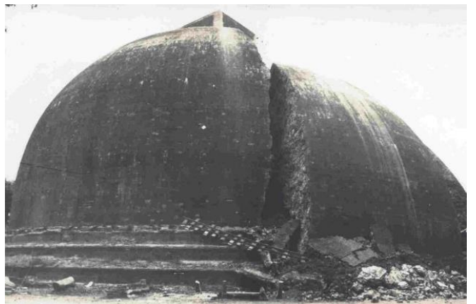
修復後のミリサウエティヤ仏塔ドームの崩壊：1980年代の2回目の試み
