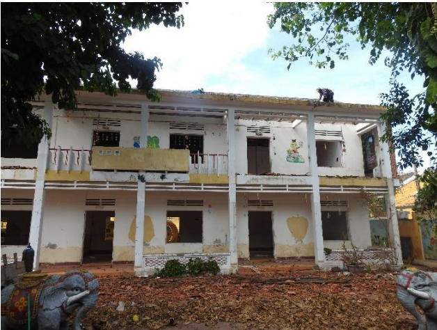
解体された2階建ての教室
