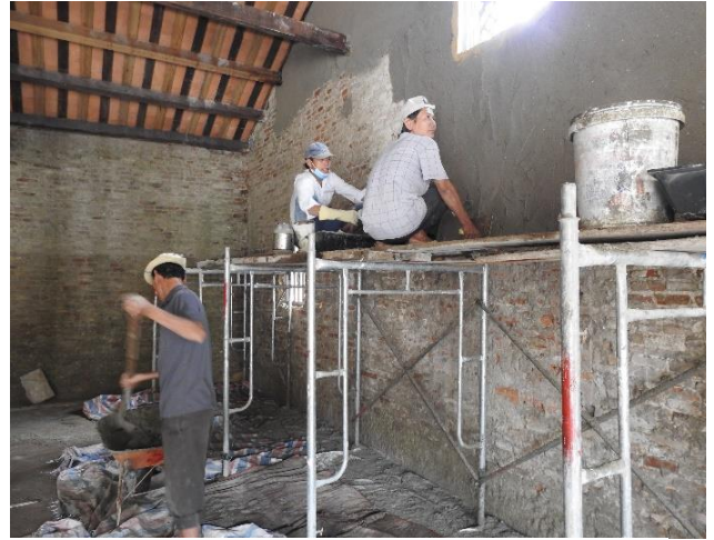
壁に石灰モルタルを塗っているところ
