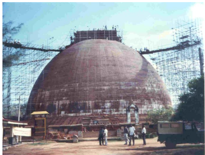
ドームが完成し、方形小室は一部完成している。
