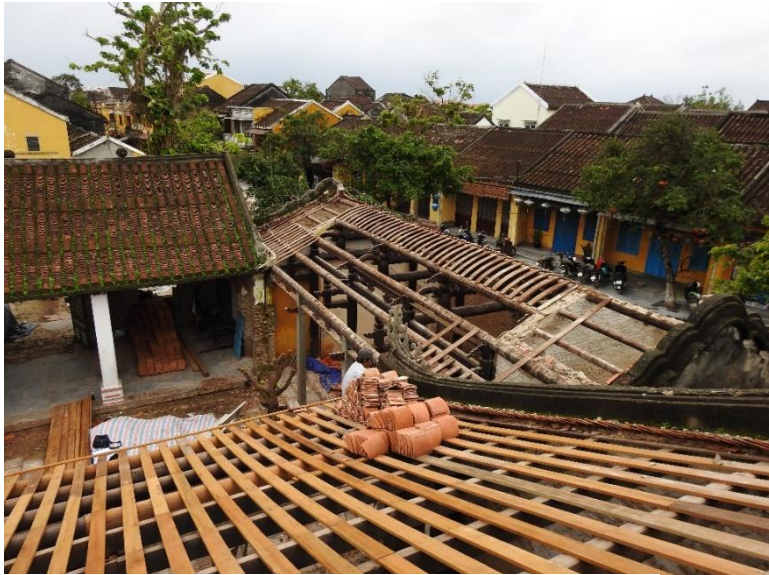
公民館の屋根の修復
