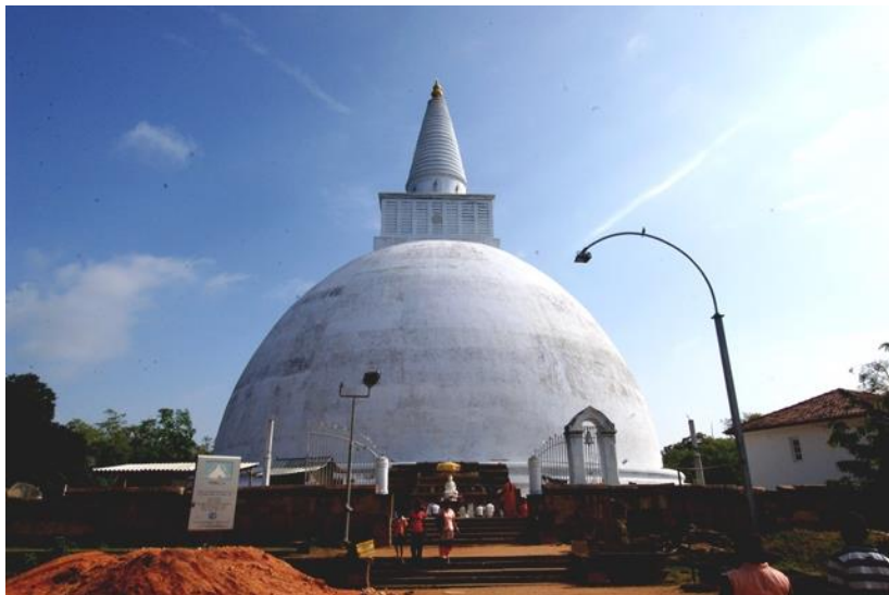
新たにモルタルを施した修復後のミリサウエティ仏塔
