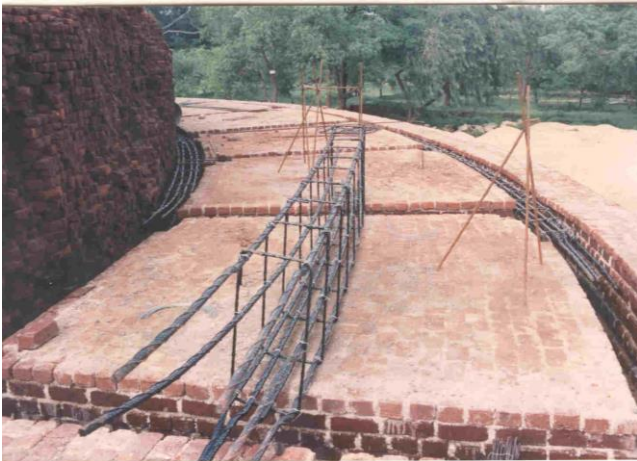
鉄筋コンクリートを基部輪に打設する前
