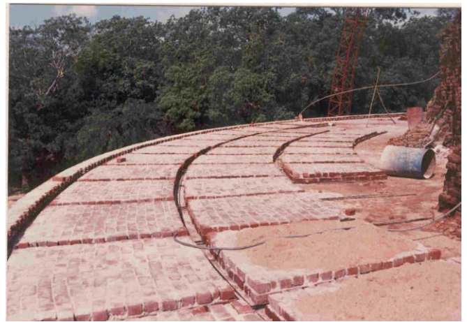
鉄筋コンクリートを基部輪に打設する前
