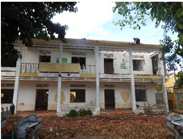
解体された2階建ての教室
