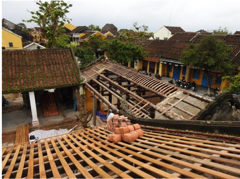
公民館の屋根の修復
