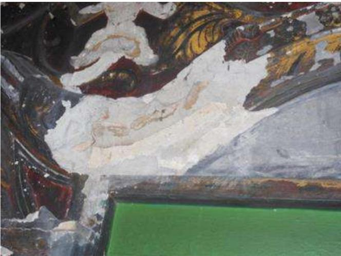
図17. ドラゴン・アーチ (Makara Torana) の漆喰の剥落 (壁番号 no.A2)
