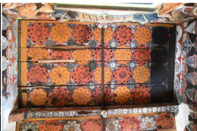
図 24. 煤の化学洗浄後 (木天井)
