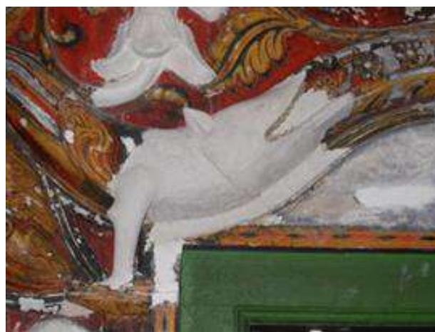
図 26. 石灰漆喰を用いたドラゴン・アーチの強化作業の様子
