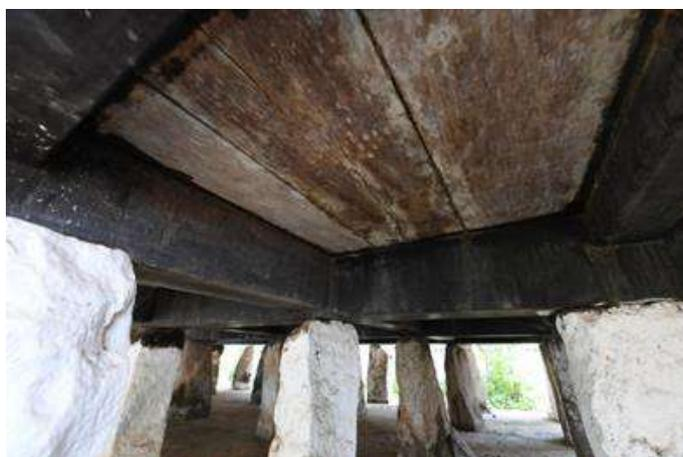
図6. セイロン・アイアンウッド (*mesua ferrea*) 製の梁
