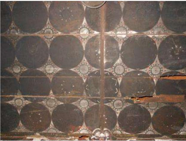
図15. 化学洗浄前の板天井
