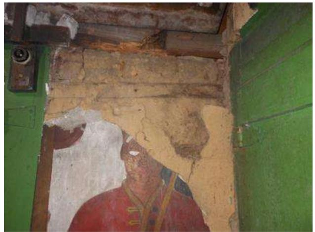
図16. 支持内部の脱落部分 (壁番号 no.A)
