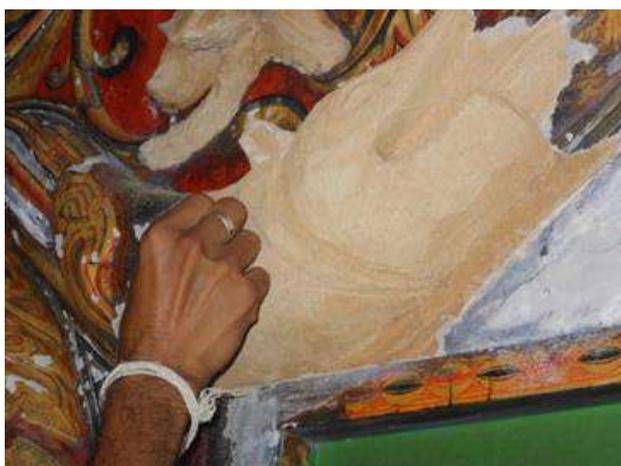
図 25. 粘土漆喰を用いたドラゴン・アーチの強化作業の様子
