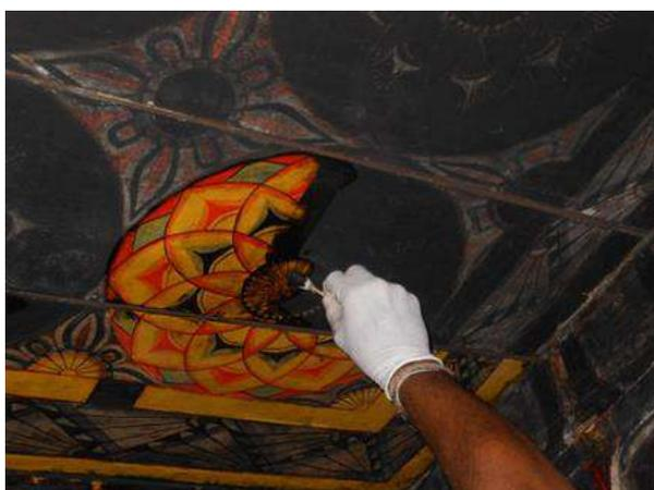
図 23. 薬品洗浄によるすす落とし (木造天井 No. 4)
