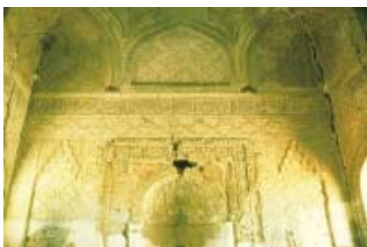
⑥a キブラ壁の屋内の様子、メフラーブの覆いとドームを支えているスキンチ(アーチ)を見上げる Interior view of qibla wall looking up to the mihrap hood and the squinches supporting the dome
