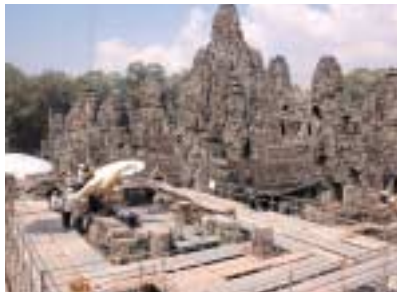
バイヨン寺院南経蔵の解体
