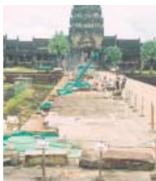
アンコールワット西参道の修復作業
