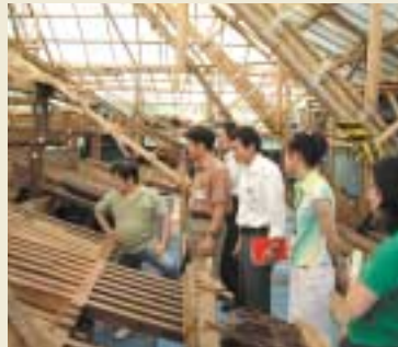
麻生寺大師堂の保存修理工事現場での研修
