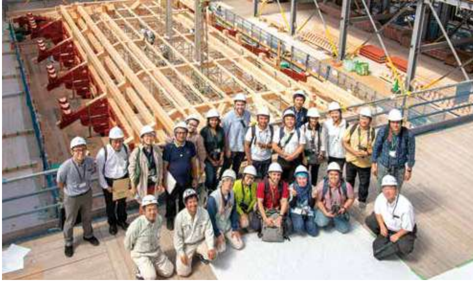
臨地研修(平城宮第一次大極殿院南門 復原整備工事現場)
