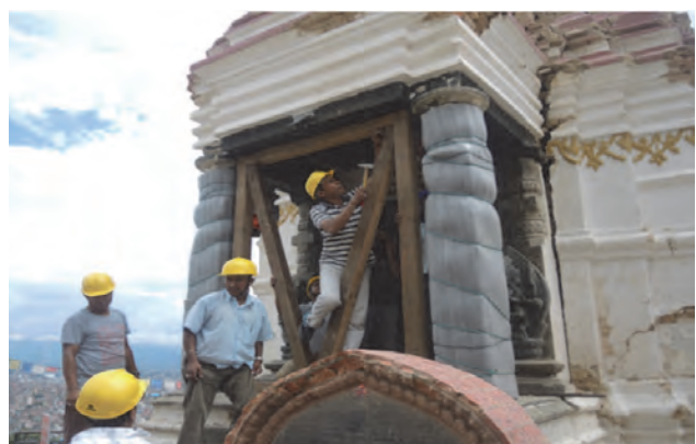
Fig. 13 Emergency stabilization of structures and heavy objects. Source: Aparna Tandon 図13 歴史的建造物の災害時安全化処理 提供：アパルナ・タンドン
