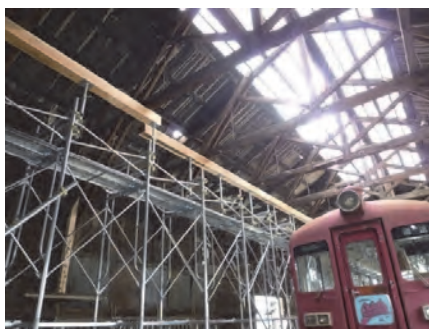
写真6 足場による補強 Photo 6. Reinforced with scaffolding
