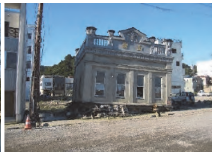
写真2 1・2階部分が流失 Photo 2. Floors 1-2 washed away
