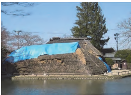
写真1 柱が全て折損した事例 Photo 1. All pillars collapsed
