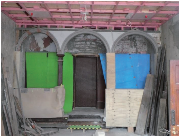
図 7. 旧市議会議場、改造された図書館のアーチ部分と新たに設置されたせん断壁。写真：2023 年 11 月、ガレス・ライトが撮影
