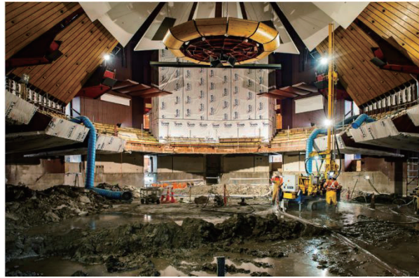
図 11. クライストチャーチ・タウンホールの床の修復作業。写真：CCC 収蔵物
