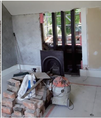
図 5. 旧ベルファストスクール教員住宅、新しく取り付けられた鉄筋構造の煙突の枠組と再利用されるレンガ。写真：CCC 収蔵物
