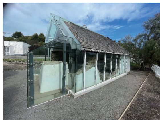
図 3、3a. ペンフォールド船長の家の修理と補強。ガラスを取り付けた拡張部分は元々の煙突の形を表している。 写真：2023 年 11 月、デボラ・コスグローブが撮影
