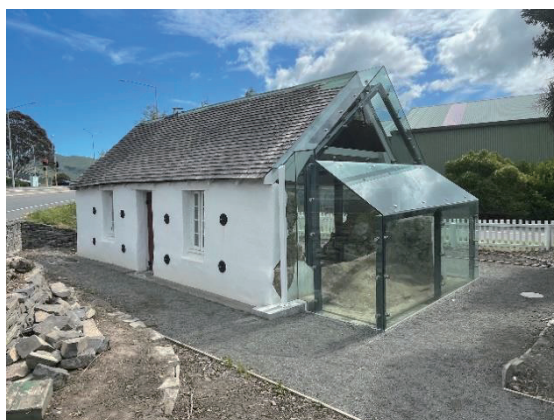
図 3、3a. ペンフォールド船長の家の修理と補強。ガラスを取り付けた拡張部分は元々の煙突の形を表している。 写真：2023 年 11 月、デボラ・コスグローブが撮影
