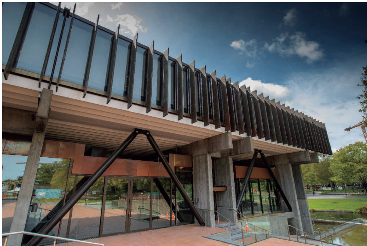
写真8 新たに構造支柱が追加された新しい大会議場（下）とライムズ・ルームの再建された柱（上）。クライストチャーチ・シティカウンスル撮影（2019年）
