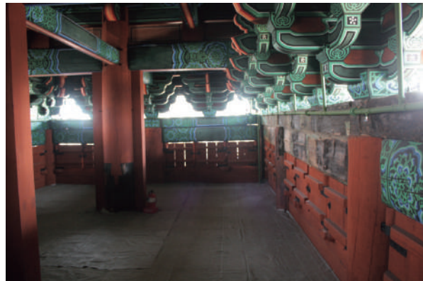
写真 4 木材の表面に残る火災の痕跡
